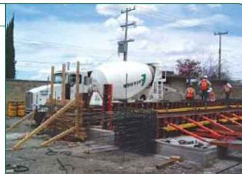
Columna Prefabricada, Cuautla, Mor.
