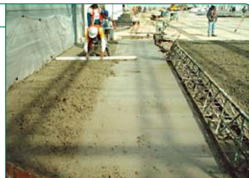
Area de Carga y Descarga, Cuautitlan, Edo. de México
