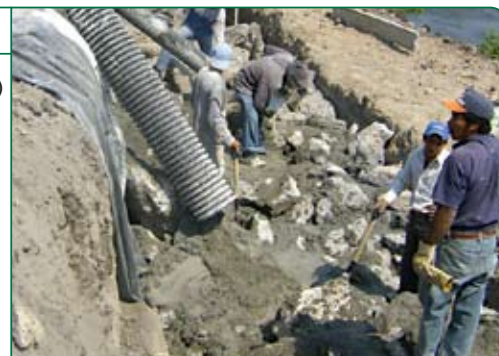
Muros de Mampostería, Tezoyuca, Morelos
