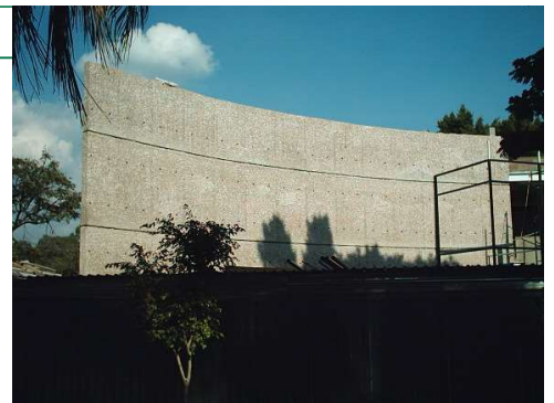
Concreto con mármol expuesto, Cuernavaca, Mor.
